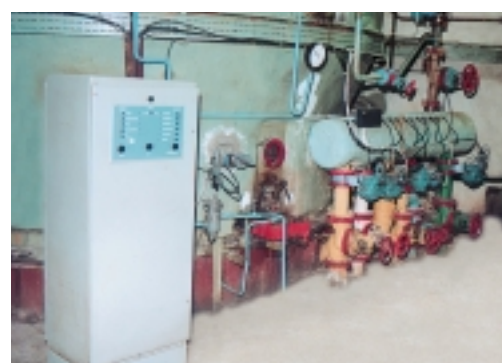
Датчики и исполнительные устройства системы автоматизации вакуум-аппарата
