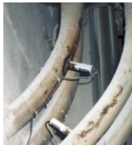
Рис. 2. Датчики заправки на входных трубах силосов
