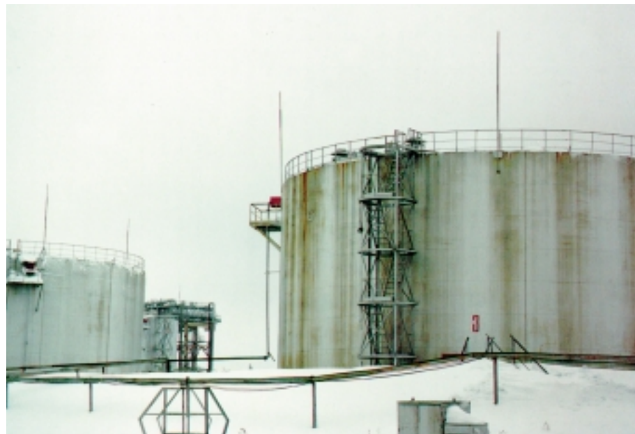
Рис. 1. Общий вид резервуарного парка
