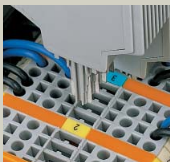
Безошибочная установка модулей обеспечивается кодировочными элементами
