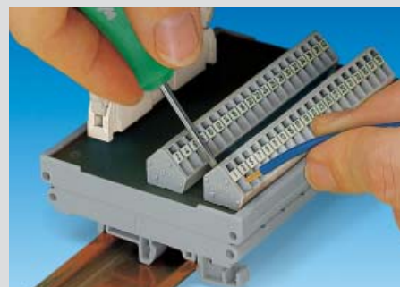
Подключение проводников с помощью изогнутой отвёртки
