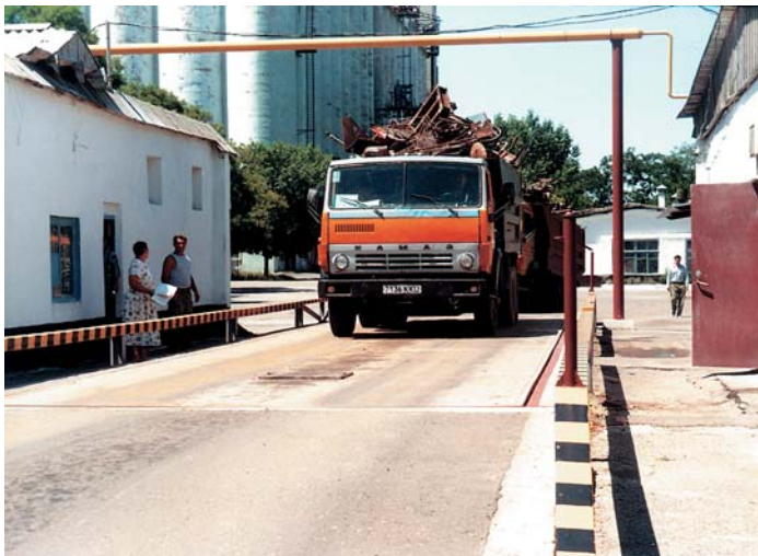
Рис. 5. Ейский портовый элеватор: автомобильные весы 2РС60-ДА
