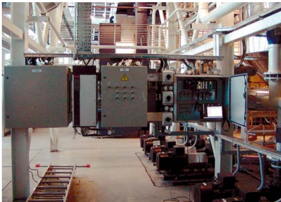
Рис. 2. Станция распределённого ввода-вывода ET200M
