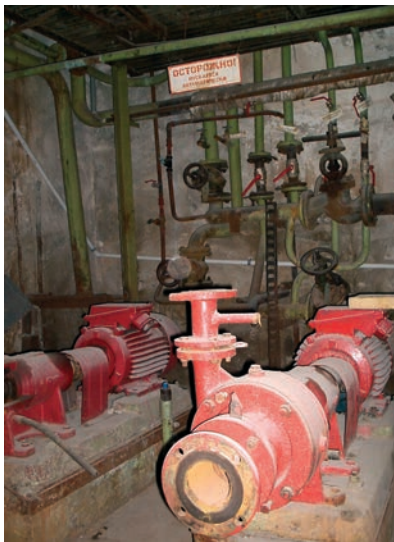
Рис. 5. Препятствующая насосная в состоянии демонтажа
