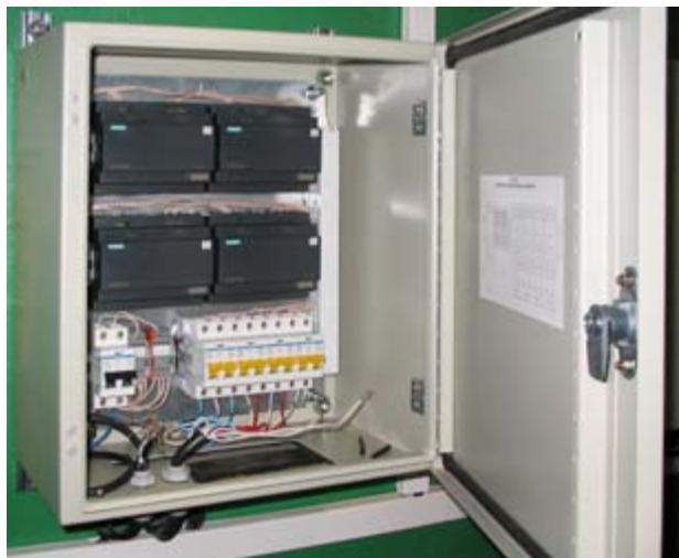
Рис. 7. Монтаж блока БП-240
