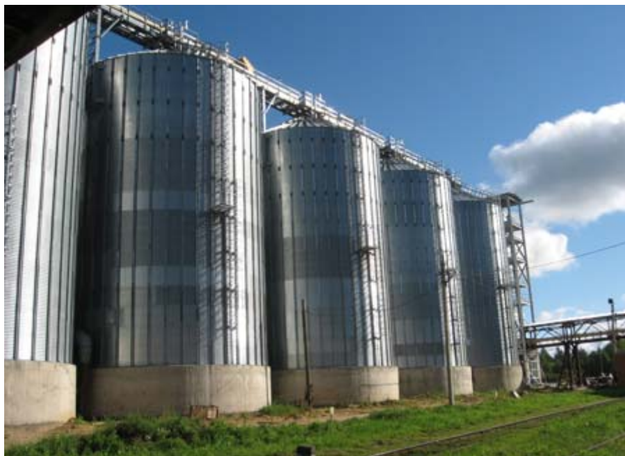
Рис. 1. Силосный корпус элеватора
