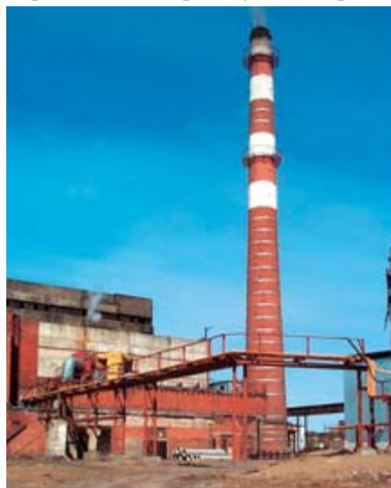
Рис. 2. Утилизационная котельная Краснокамского целлюлозно-бумажного комбината
