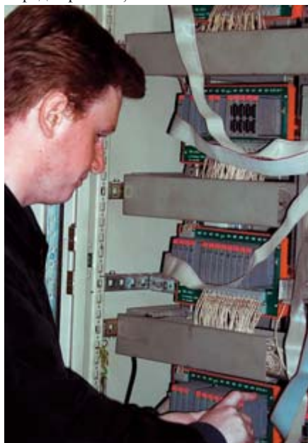
Рис. 8. Клеммные платы TBI-24L обеспечивают простой монтаж УСО фирмы Grayhill
