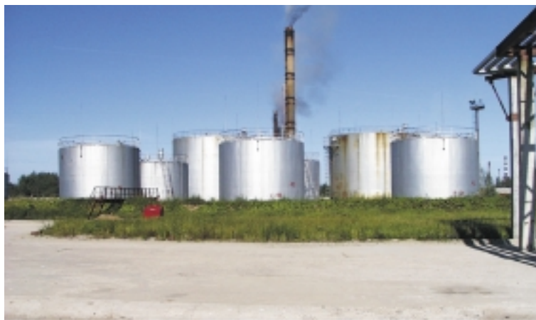
Резервуары топлива на нефтебазе КИНЕФ
