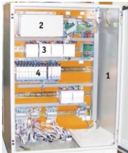
Рис. 7. Локальная технологическая станция системы измерения уровня и температуры (1 — электротехнический шкаф серии CONCEPTLINE фирмы Schroff/Hoffman, 2 — контроллер PCA 6145B в корпусе MBPC641 фирмы Advantech, 3 — блоки питания системы, 4 — барьеры искрозащиты фирмы Elcon)
