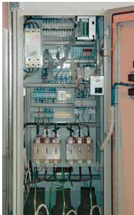
Рис. 8. Электрический шкаф с аппаратурой системы управления стандом тестирования погружного электродвигателя
