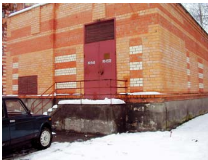
Здание распределительного пункта электросети
