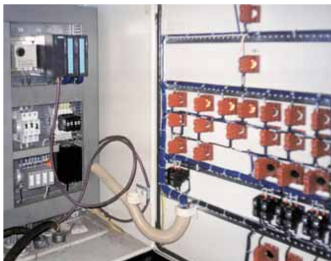
Рис. 6. Размещение станции SIMATIC ET 200M внутри пульта управления гидростанцией
