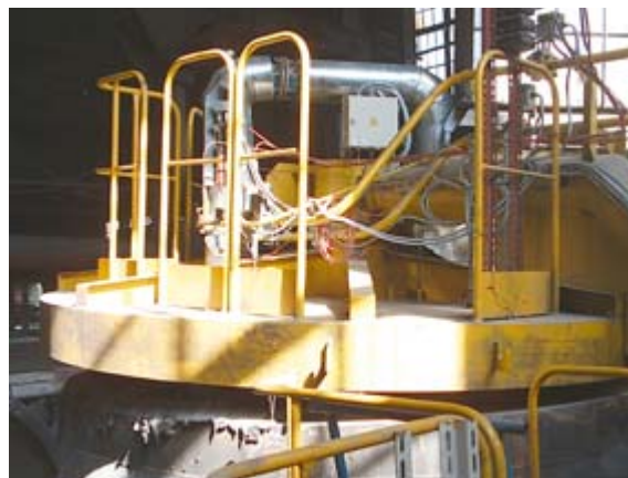
Рис. 2. Крышка стенда сушки ковшей
