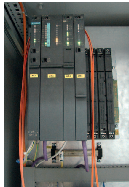
Рис. 5. Программируемый логический контроллер системы МПЦ
