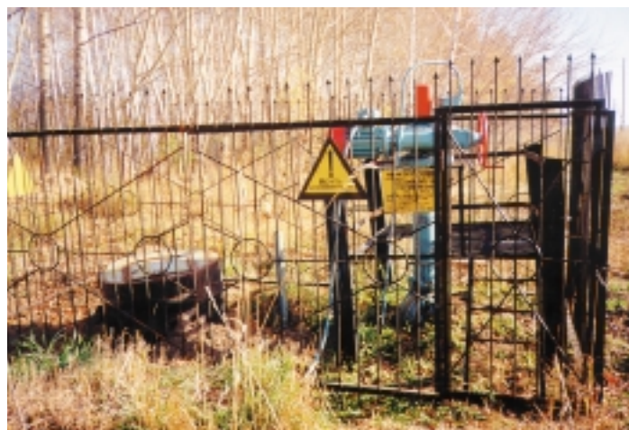
На трассе нефтепровода
