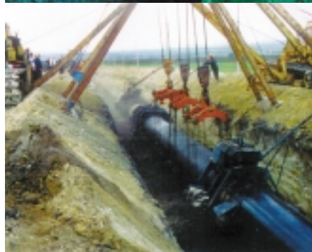
Так начинается жизнь магистрального нефтепровода
