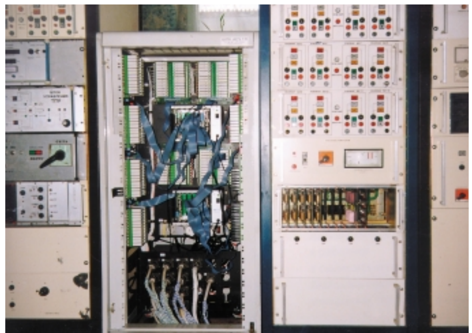
Рис. 9. Установка оборудования в шкафах
