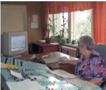
Рис. 3. Рабочее место дежурного по станции
