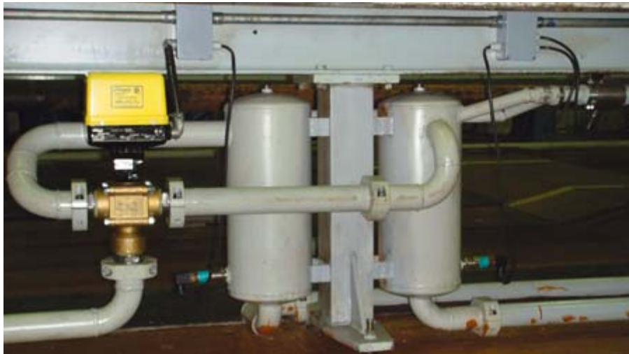
Рис. 2. Ресиверы масла и тосола с сигнализаторами уровня и воздушными клапанами
