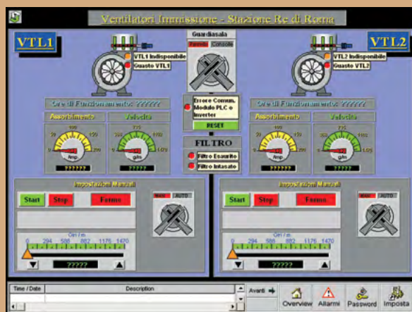
Контроль и управление вентиляцией для Rome Metro S.p.A.
