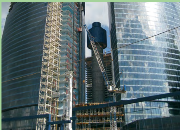
Строительство башни «Федерация» Москва, Россия
