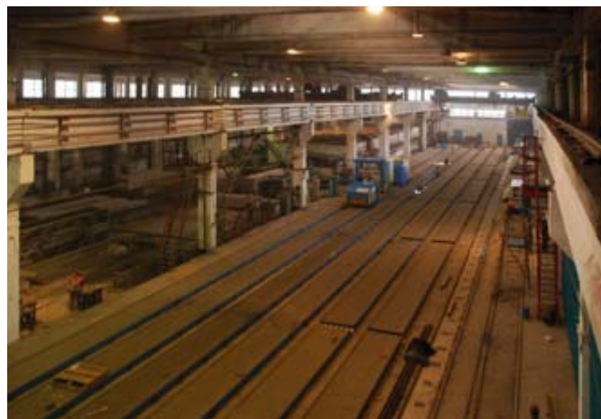
Линия по производству плит перекрытия
