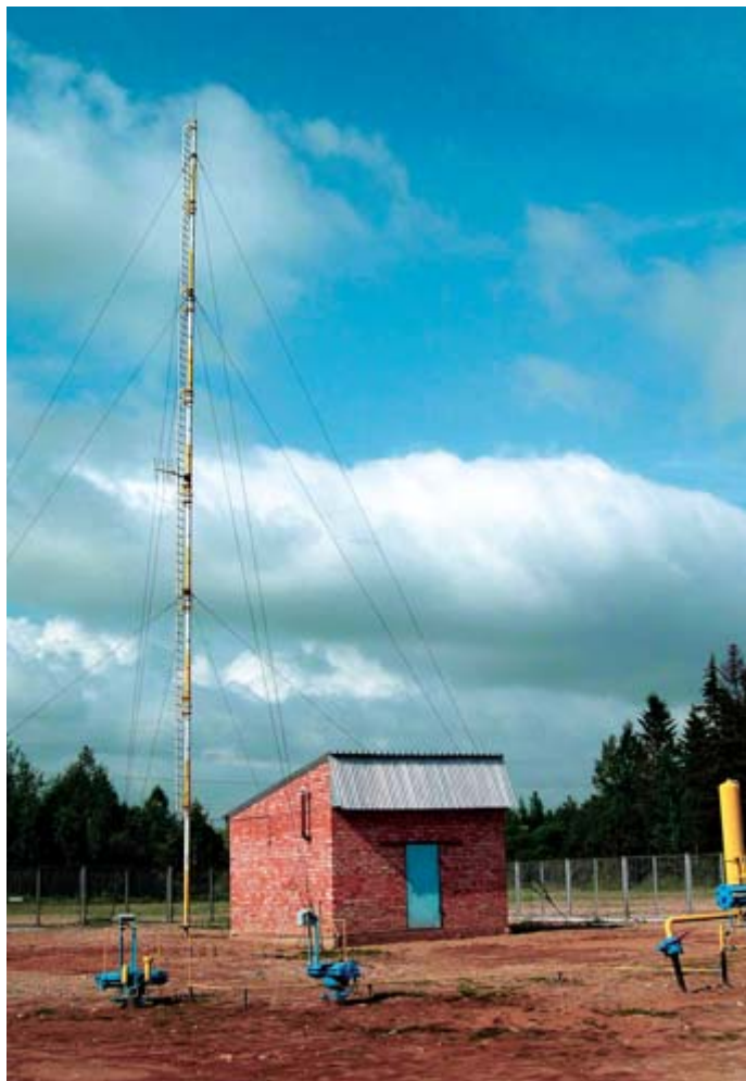
Рис. 1. Блок-бокс контролируемого пункта кранового узла
