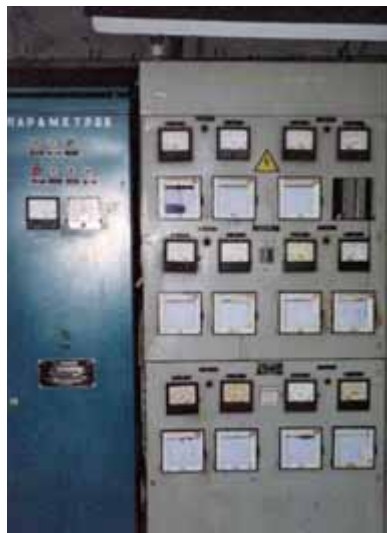
Рис. 2. Щитовые самопишущие приборы типа НЗ092
