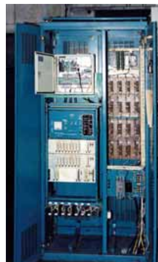
Рис. 5. Внешний вид шкафа сбора информации с модулем М1
