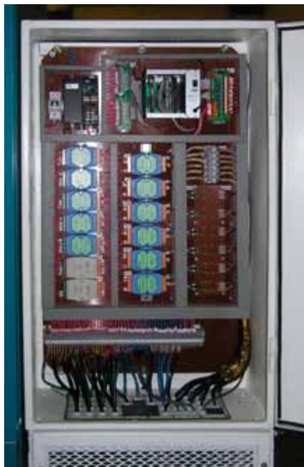
Рис. 5. Модуль сбора информации о параметрах работы главных электроприводов непрерывной группы клеток 500
