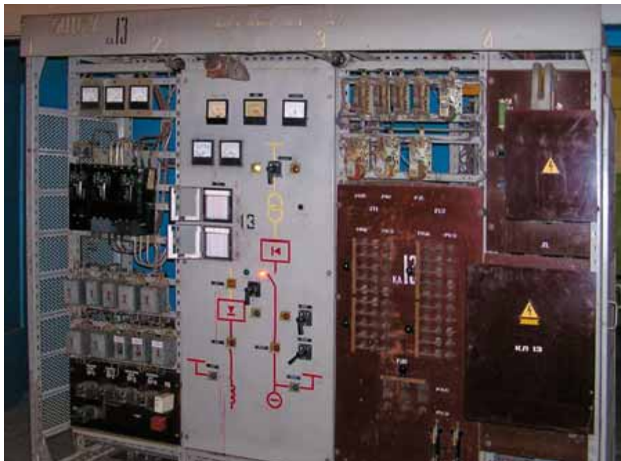
Рис. 3. Панель управления главным электроприводом прокатной клетки непрерывной группы 500 с приборами контроля и регистрации
