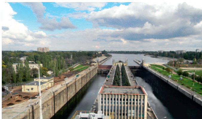
Рис. 3. Вид на шлюзы с поста управления
