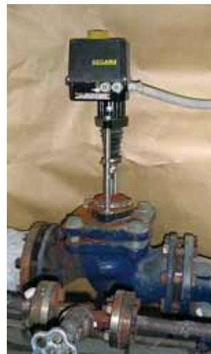
Рис. 2. Запорно-регулирующий клапан подачи пара
