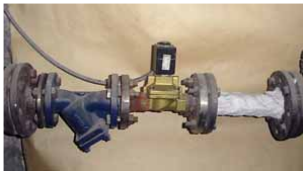
Рис. 3. Электромагнитный клапан подачи пара в камеру
