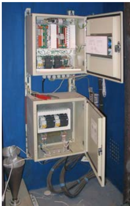
Рис. 5. Монтаж блоков Б1-БАРС 322 и БП-120
