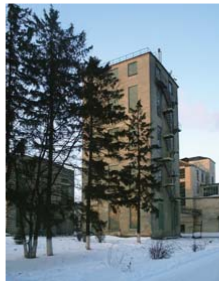
Козловский спиртовой завод, здание брагоректификационной установки
