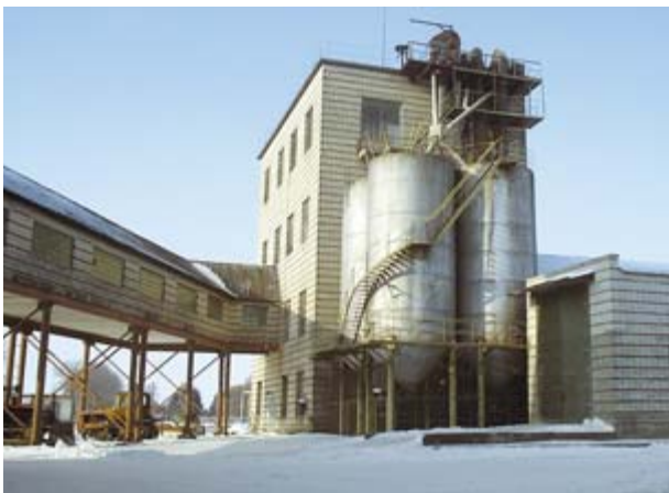
Рис. 1. Здание размольного участка ГП «Козловский спиртовой завод»
