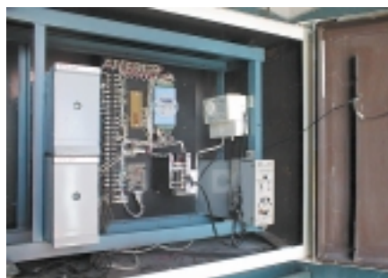
Рис. 5. Шкаф преобразователей и модуля ввода сигналов
