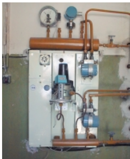
Рис. 3. Вариант исполнения щита измерительных и сигнализирующих приборов и датчиков
