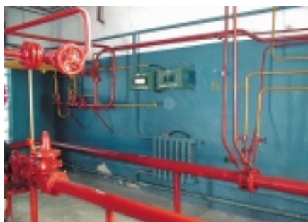
Рис. 1. Оборудование ГРП: трубы-отводы для датчиков
