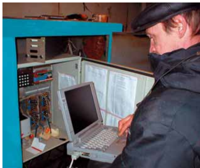
Рис. 3. Периферийное устройство регистрации с открытой крышкой шкафа
