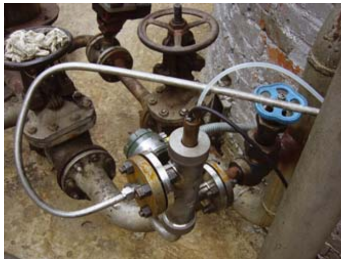
Рис. 4. Метрологический комплекс определения уровня pH
