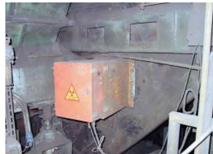
Рис. 2. Установка датчика в весовой воронке доменной печи
