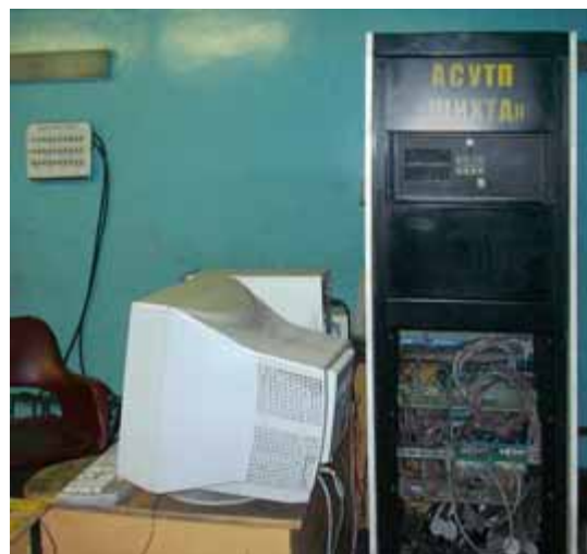
Рис. 3. Внешний вид шкафа управления с центральным контроллером, реализованным на базе промышленного шасси IPC-623
