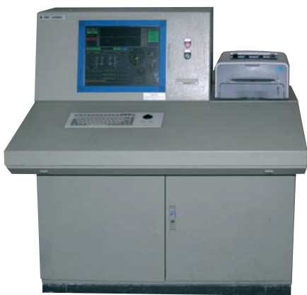
Рис. 2. Рабочая станция дежурного электрика обжимного цеха
