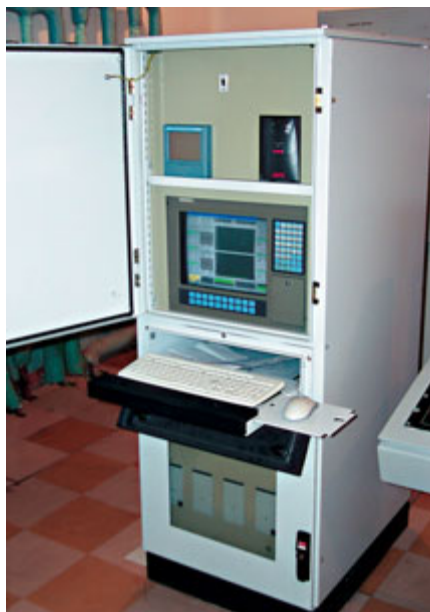
Рис. 2. Общий вид рабочего места оператора пресса
