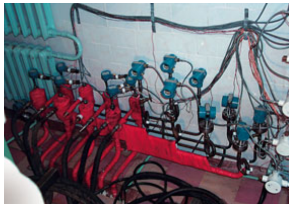
Рис. 4. Расположение датчиков в помещении пресса
