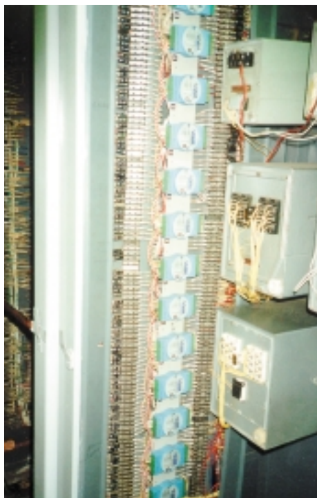
Рис. 3. Монтаж модулей ADAM-4000 в приборной панели
