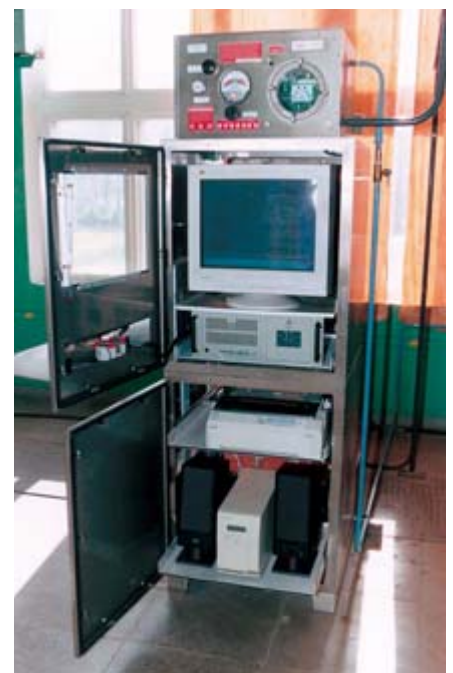
Рис. 5. Размещение вычислительного оборудования во взрывозащитном шкафу
