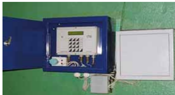
Рис. 1. Узел системы с теплосчётчиком STD-3
