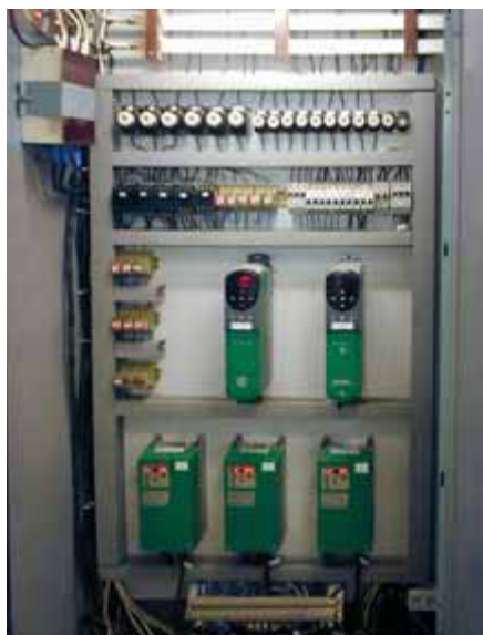
Рис. 2. Силовой шкаф управления экструзионной линией на базе частотных регуляторов UniDrive и SE-Commander
