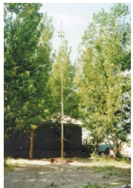
Рис. 3. Мачта поста оповещения с антенно-фидерным устройством и комплектом громкоговорителей и сирен
