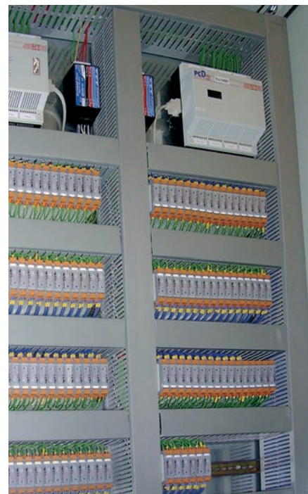
Рис. 5. Один из шкафов системы управления с программируемыми контроллерами и измерителями параметров тока и напряжения
