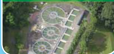
Управление системой очистки воды
