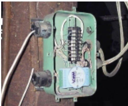
Рис. 2. Распределительное устройство с модулем ADAM-4017
