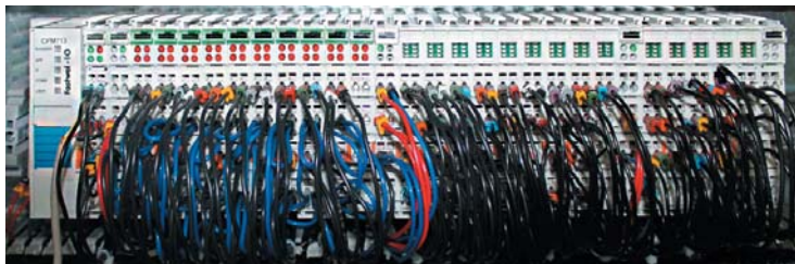
РИС. 2. ► Собранный модуль ПЛК и система ввода/вывода в ходе монтажа шкафа
